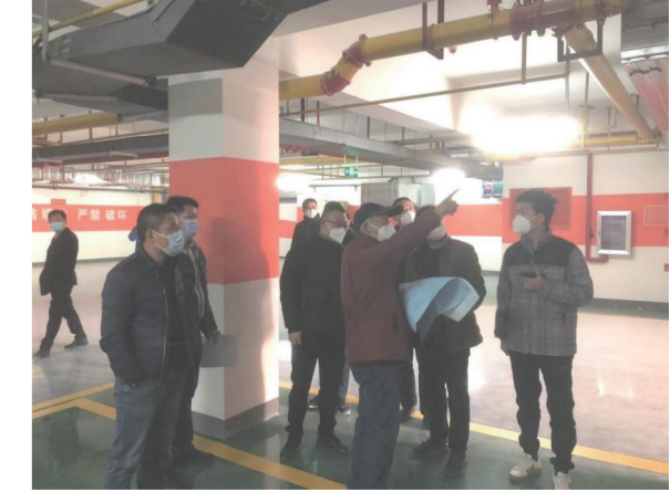
黄冈东方明珠B区项目人防地下室工程竣工验收
