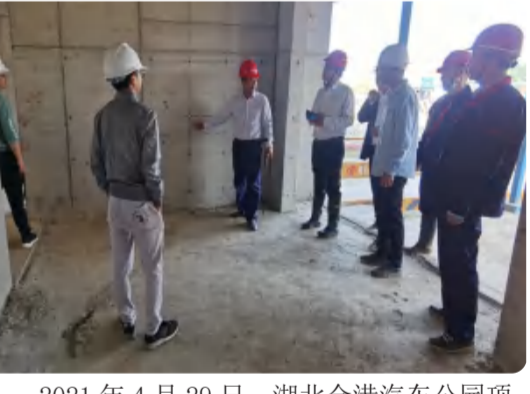
2021年4月29日，湖北金港汽车公园项目甲方、监理组织安全综合检查。
